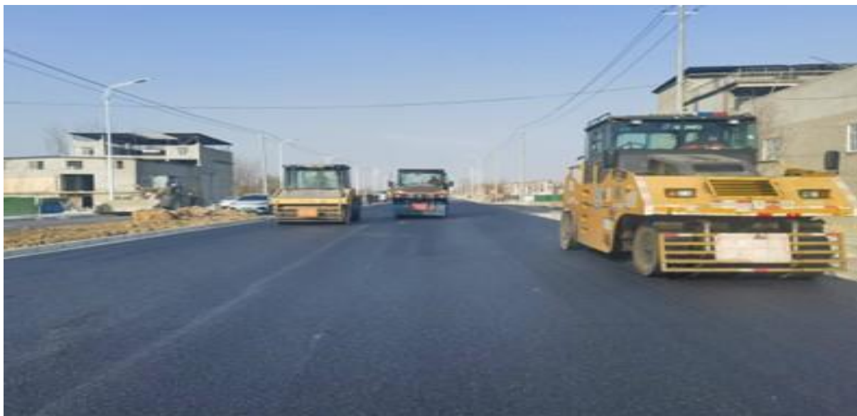
图：进出港大道 K2+175-K3+114 段左幅上面层沥青碾压
