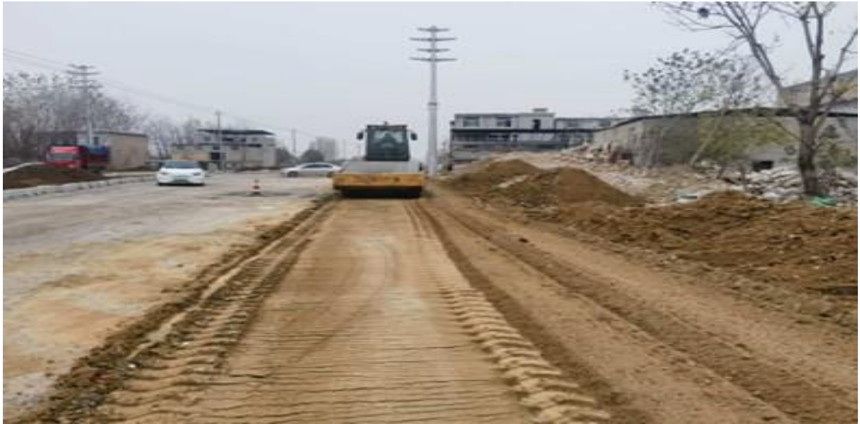
图：进出港大道 K2+580-K3+114 段左右幅人行道 12%灰土施工
