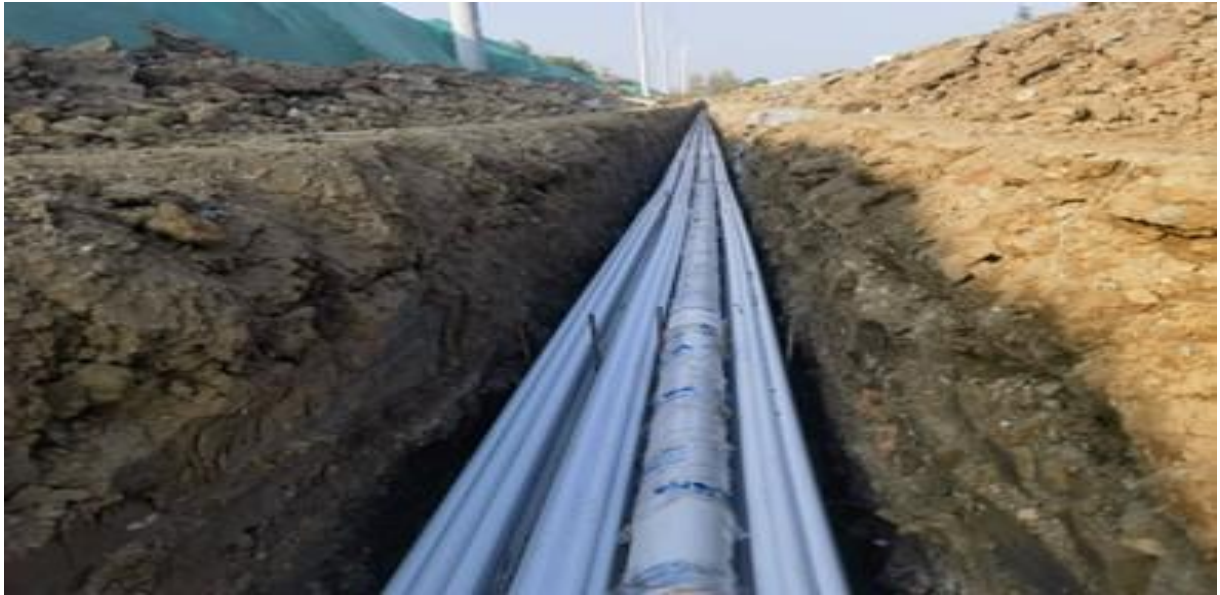
图：进出港大道 K2+580-K2+900 段弱电工程管道安装
