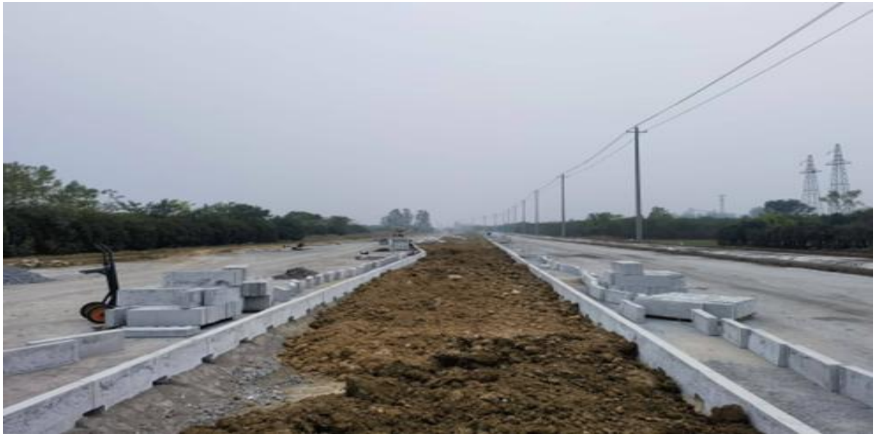
图：进出港大道 K1+200-K2+000 段中央分隔带侧石安装施工现场
