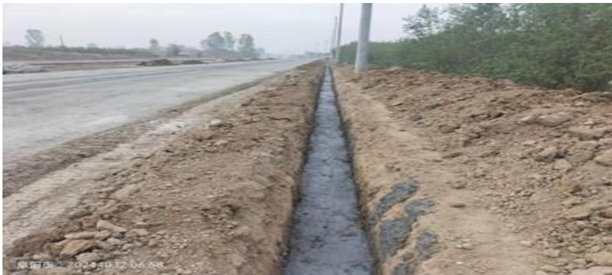
图：进出港大道 K1+320-K1+520 段弱电工程砼垫层施工现场
