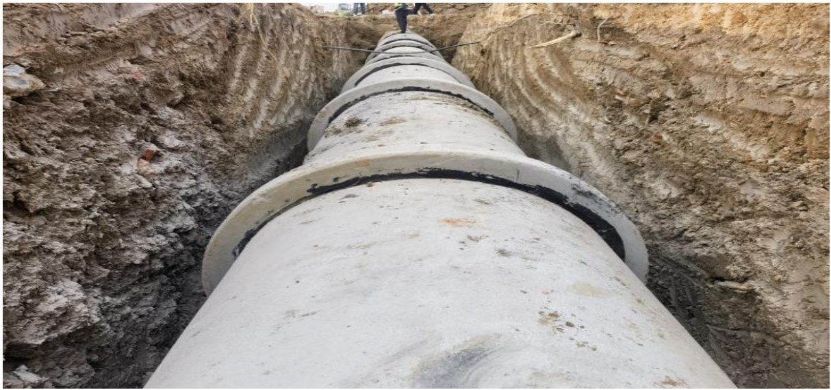
图：进出港大道 K2+720-K2+780 雨水管道安装施工现场
