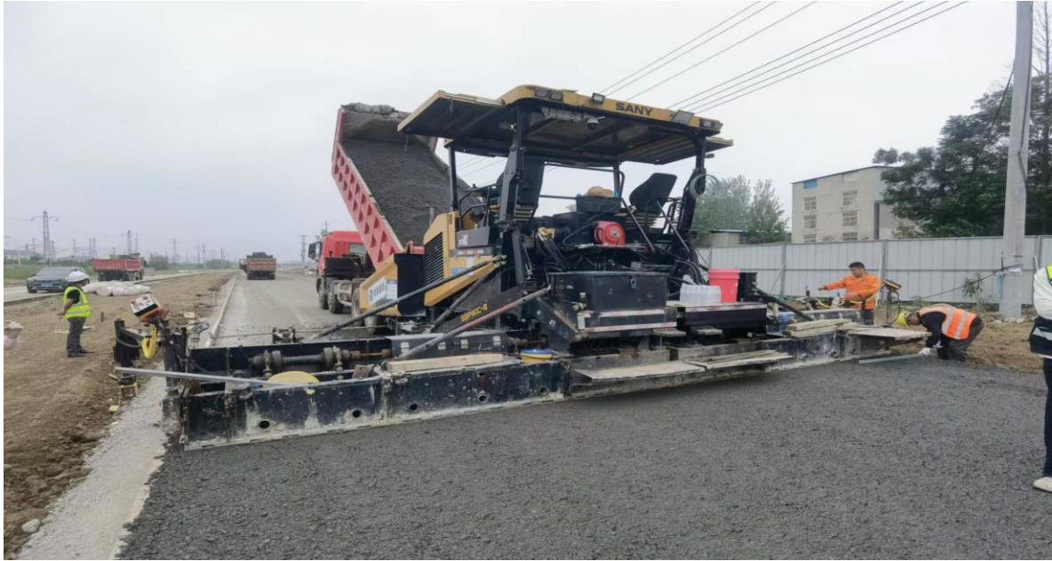
图：进出港大道 K0+000-K0+700 段右幅第三层 5%水稳摊施工现场
