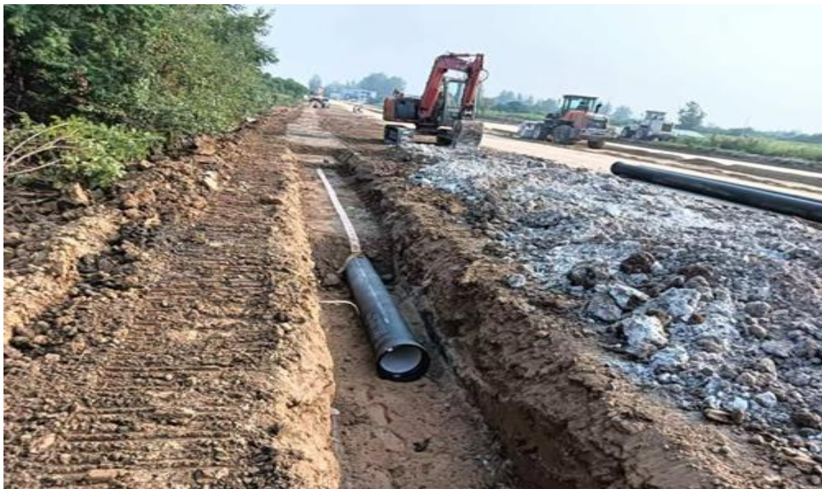
图：进出港大道给水管道施工现场
