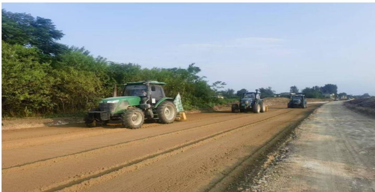
图：进出港大道 K1+700-K2+000 左幅 6%灰土第 2 层灰土拌合施工现场
