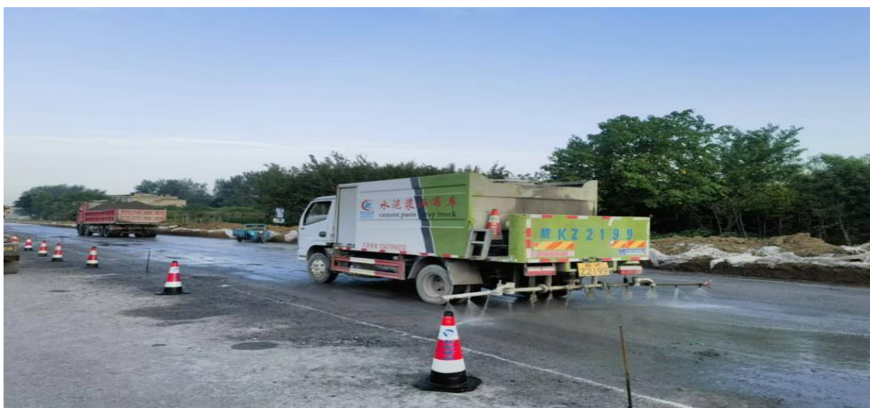
图：进出港大道 K0+000-K1+260 段右幅洒布水泥净浆施工现场
