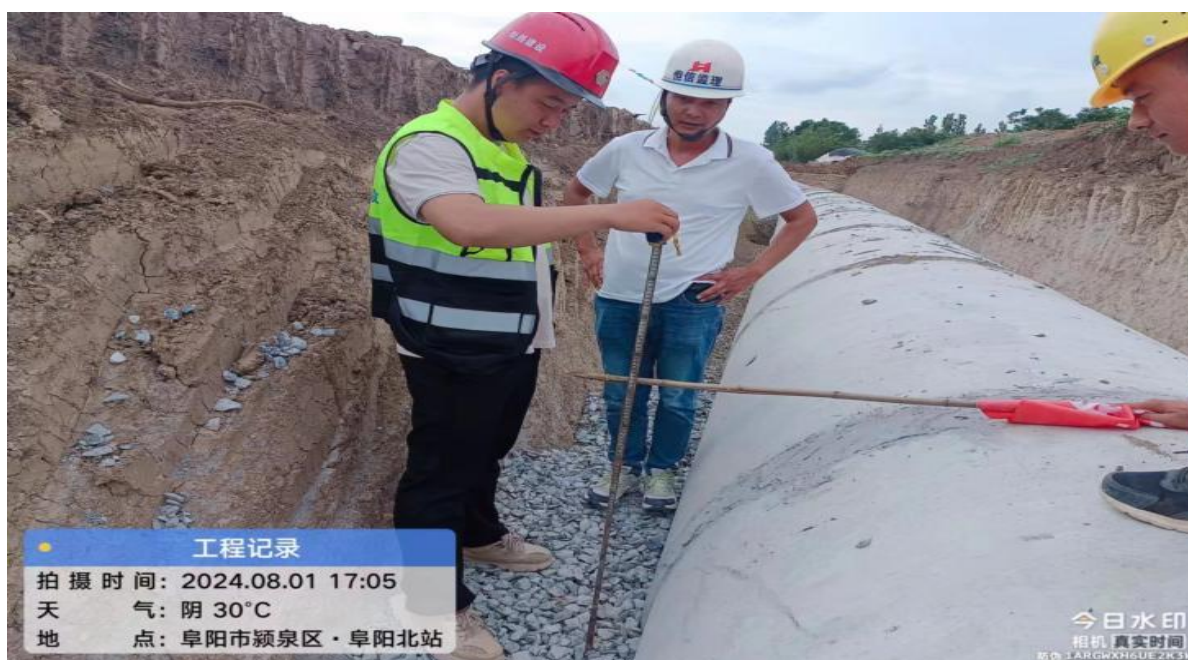
图：进出港大道雨水沟槽验收 180° 腋角回填施工现场
